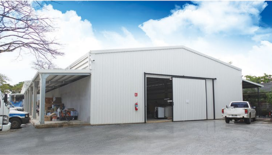
Thanawut Warehouse - Nakhon Si Thammarat
